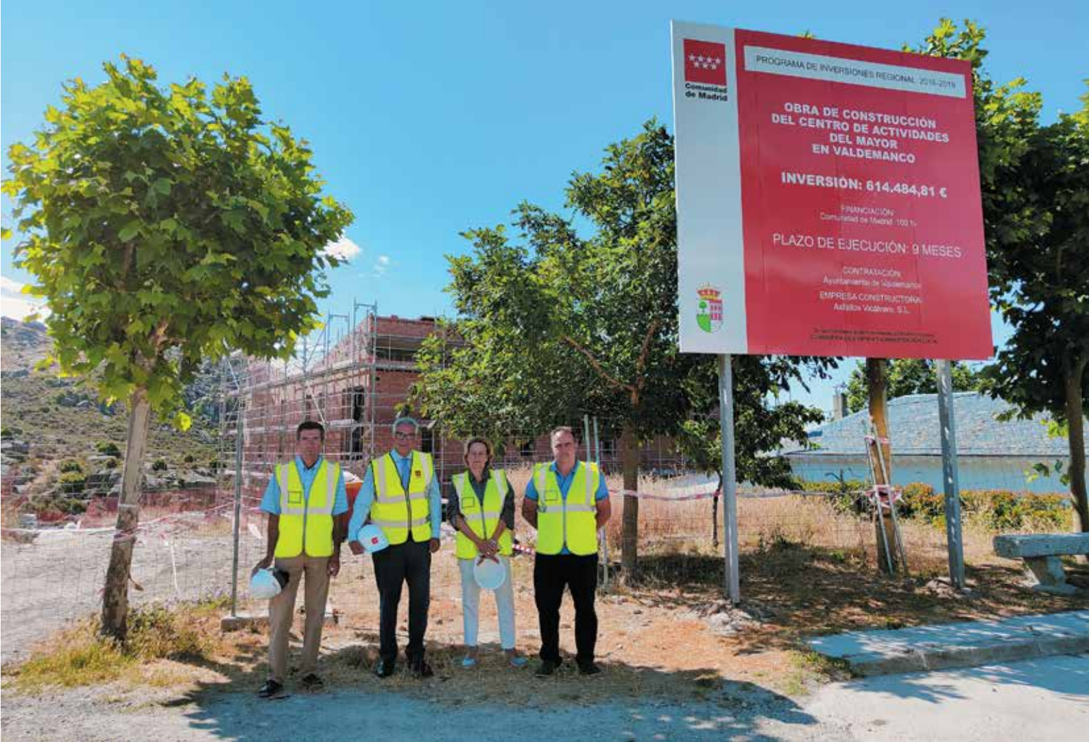
El consejero de Administración Local y Digitalización, Carlos Izquierdo, visitando la construcción del centro de mayores de Valdemanco.
