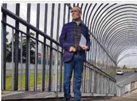
2 @CsPozuelo solicita al gobierno local la urgente reparación de las pasarelas peatonales en la Carretera de Carabanchel #Pozuelo
