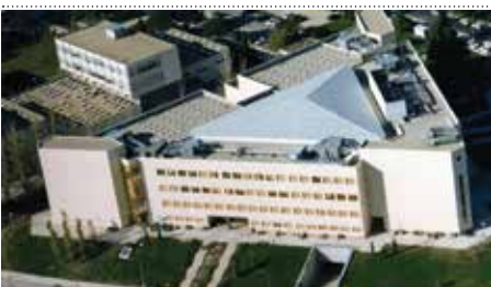
41 PSOE pide la construcción de una residencia universitaria en Pozuelo Pueblo o La Estación.
