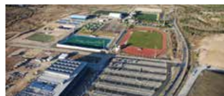
18 El Ayuntamiento construirá una pista de deportes cubierta en Valle de las Cañas. Ω
