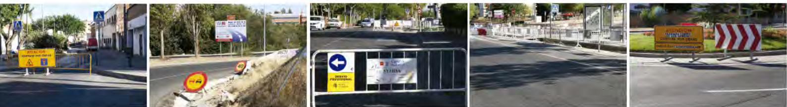
Imágenes de algunas de las obras en Pozuelo este verano.
